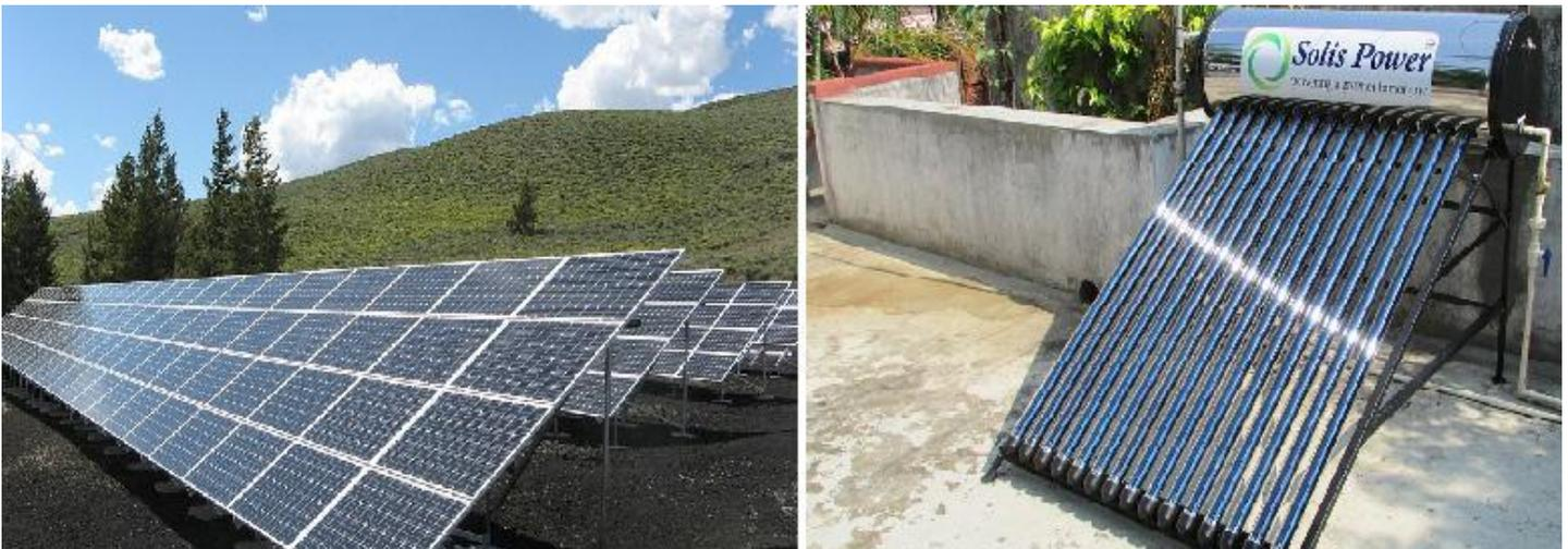
ILUSTRACIÓN 13. PANELES SOLARES A LA IZQUIERDA Y UN COLECTOR SOLAR A LA DERECHA.
